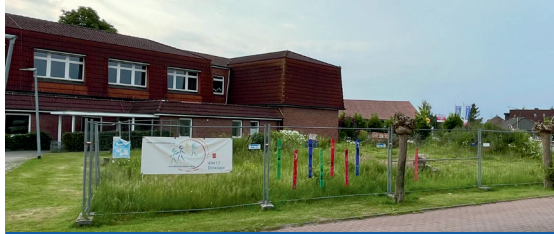
An der Grundschule Höner Mark werden neue Klassenräume und eine Mensa direkt am vorhandenen Gebäude angebaut. Fertigstellung 2027. (Kosten 3,2 Mio. €)
