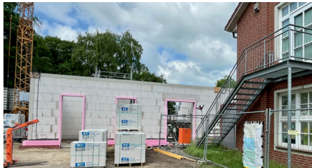
Die Bauarbeiten für eine Mensa an der Kardinal-von-Galen Grundschule haben begonnen. Fertigstellung 2027. (Kosten 2,5 Mio. €)
