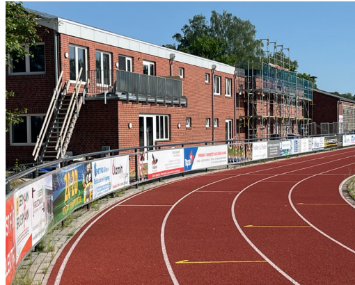
Im Jahnstadion erfolgen eine Laufbahnsanierung, die Erweiterung und Sanierung von Umkleide- und Sportträumlichkeiten sowie ein Tribünenbau. Im Herbst/Winter 2027 sollen die Arbeiten abgeschlossen sein. (Kosten für die Stadt: ca. 3 Mio. €)
