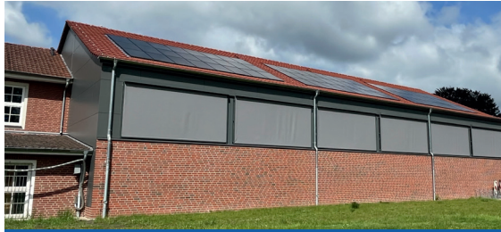
Die „alterwürdige“ Sporthalle an der Kardinal-von-Galen Grundschule wurde umfassend energetisch saniert und konnte in 2025 wieder genutzt werden. (Kosten 3 Mio. €)
